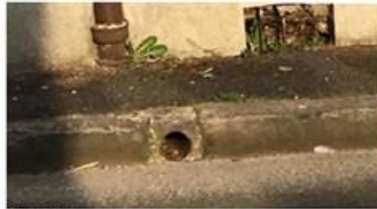
Photo 5 Sortie d'eau vers le caniveau
