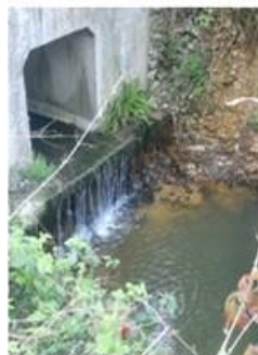
Photo 17 Ru du fond des aulnes
