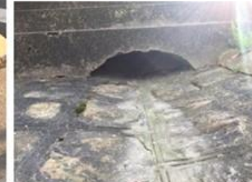
Photo 9 : chemin d'eau de pluie vers les égouts, place de la mairie
