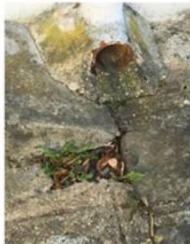
Photo 4 Sortie de la descente d'eau pluviale mairie
